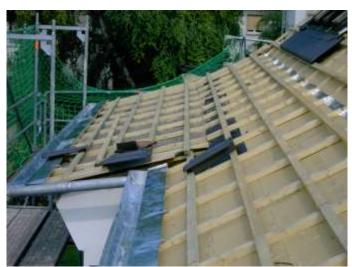
**Bildunterschrift:** Holzweichfaserplatten sind eine empfehlenswerte Alternative zur Unterspannbahn: Sie sind stabiler und bieten einen zusätzlichen Dämmeffekt.
