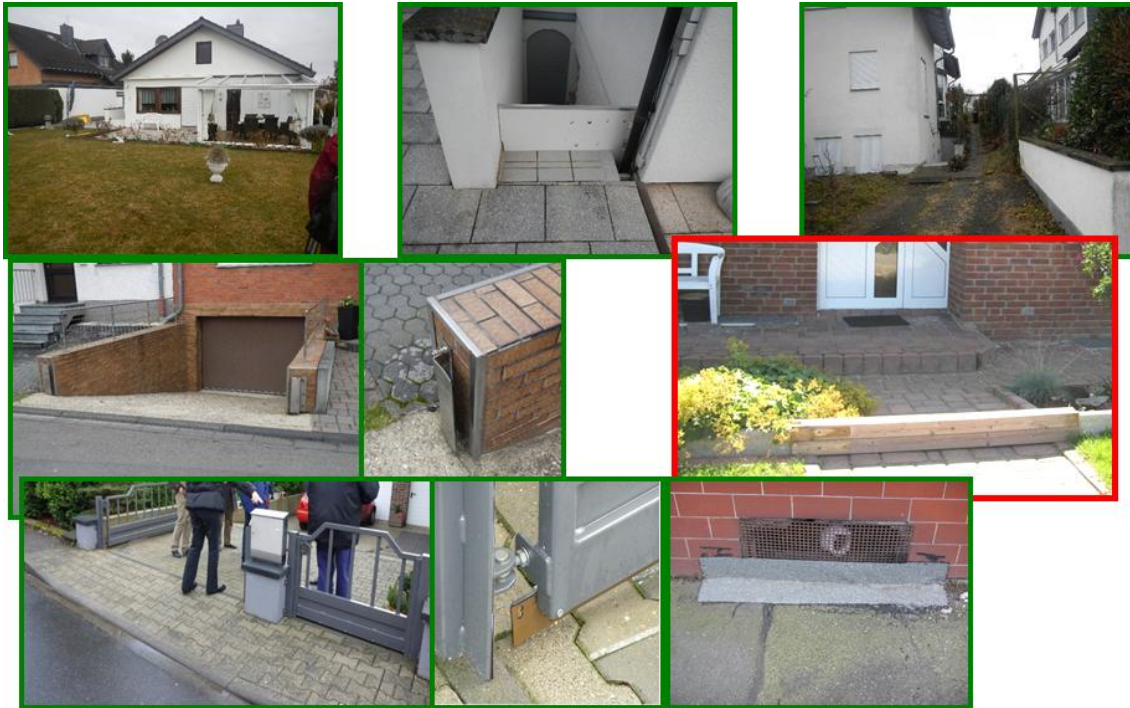
Abb. 5-51: Beispiele für Objektschutz
