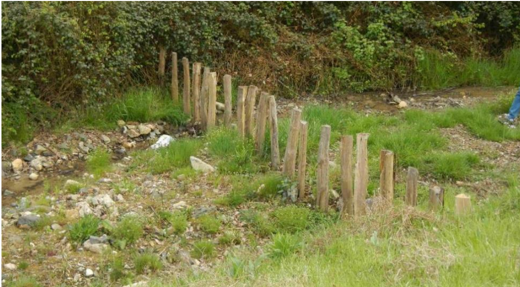
Abb. 5-13: Pfahlreihen zum Treibgutrückhalt im Vorfeld einer Verrohrung
