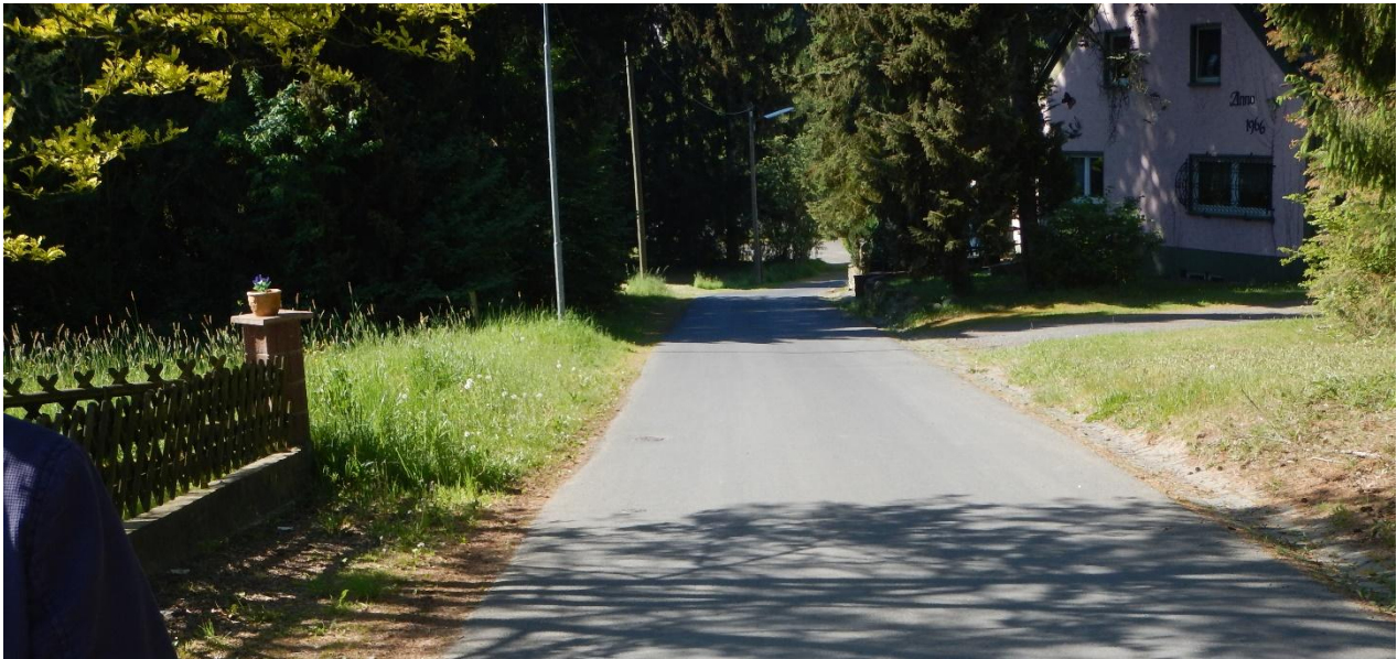
Abb. 5-52: Nicht ausgebauter Straßenquerschnitt (Krautscheid, Mittelstr.)
