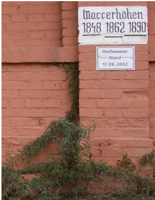
Abb. 3-3: Hochwassermarken an der Elbe unterhalb von Dresden
