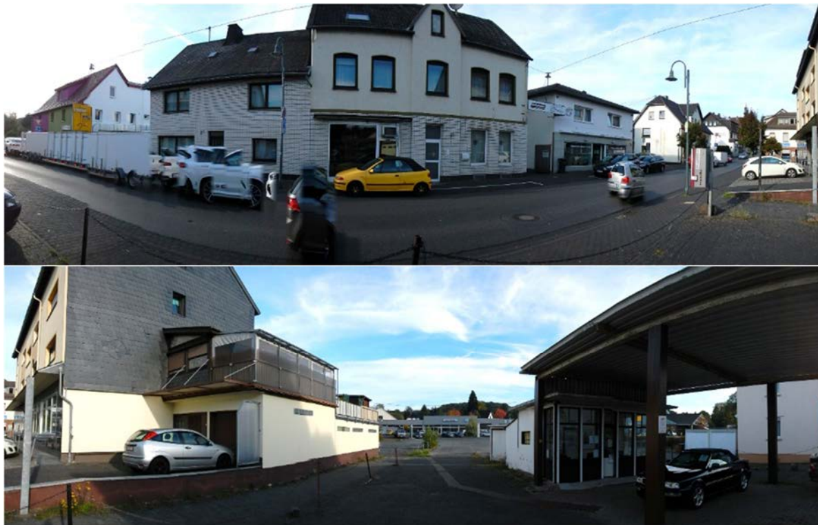
Abb. 5-32: Örtliche Situation Hauptstraße Asbach
