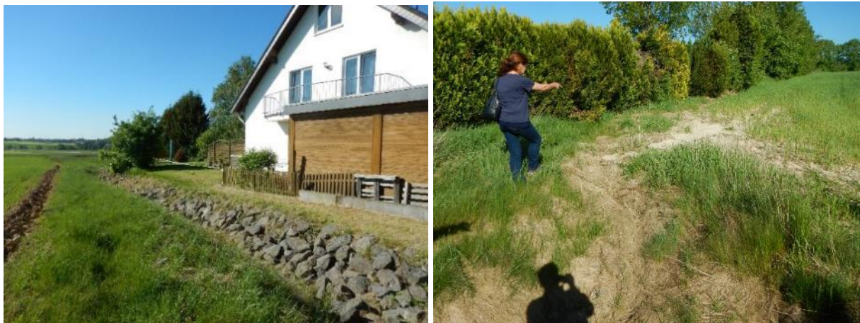
Abb. 5-19: Örtlicher Eindruck Außengebietsableitung Griesenbach (M06)
